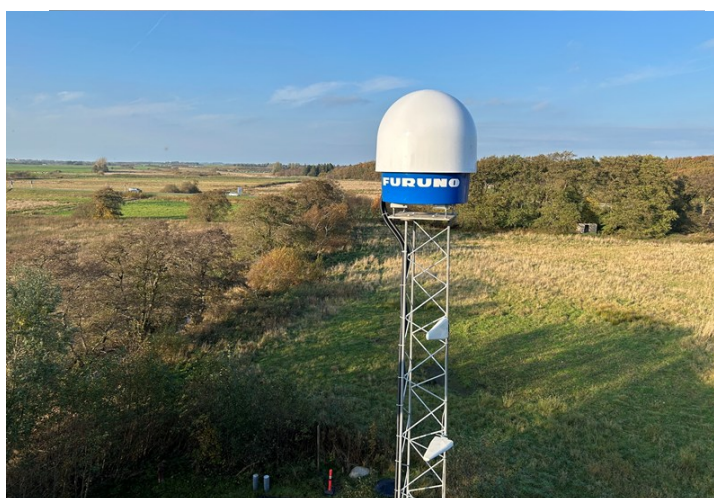
Figur 8 Viser Aalborg Forsynings x bånd radar - WR-2120. Radaren er en 100 W kompakt Dobbelt Polarimetrisk X-Bånd Doppler Vejrradar
