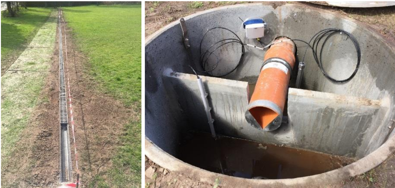
Figur 6. Linjedræn (t.h.) og flow-målerbrønd (t.v.) til henholdsvis opsamling og måling afstrømmende regnvand fra det 4.300 m 2 store græsopland i Lystrup.
