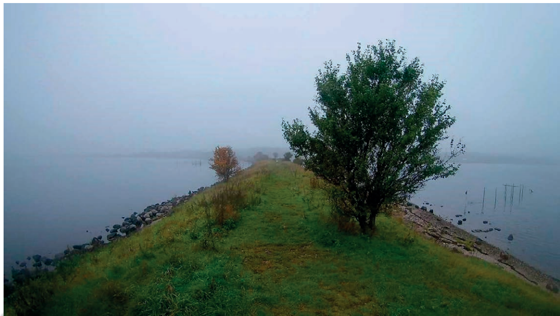
Figur 2. På billedet ses banedæmningen som var i brug, da der for næsten 85 år siden var en jernbanebro over Roskilde fjord ved Frederikssund. Den går lidt under 1 km ud fra land fra den vestlige side af fjorden. Billedet er taget fra enden af dæmningen, og man ser mod vest ind mod land. Foto: Jesper Eriksen.
