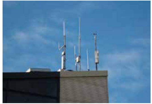
Figur 4. Nærbilledet set fra øst-sydøst af havnens måleudstyr på taget af bygningen, man ser i figur 3. Kilde: DMI's teknikere.
