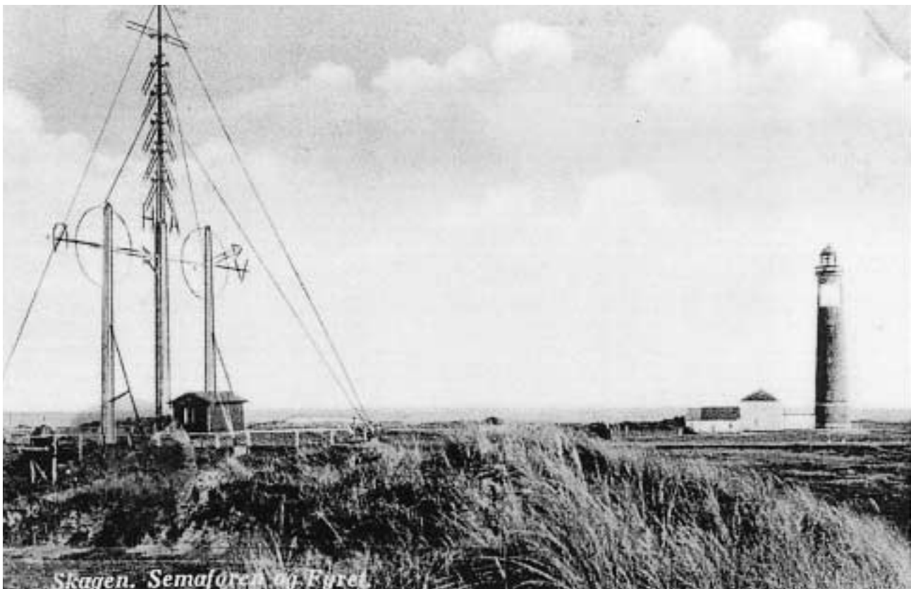
Figur 5. Visuel varslingsstation ved Skagen Fyr, der "satte varsler op" dvs. højste signaler og flag afhængig af varslet. Signalerne vist i figur 4 blev på denne lidt specielle station hejst for enderne af den tværliggende bom; ud for Ø og V. Dette gjorde Danmark til foregangsland ved visuel varsling. Blev først afløst ved radioens indførelse omkring 1925.
