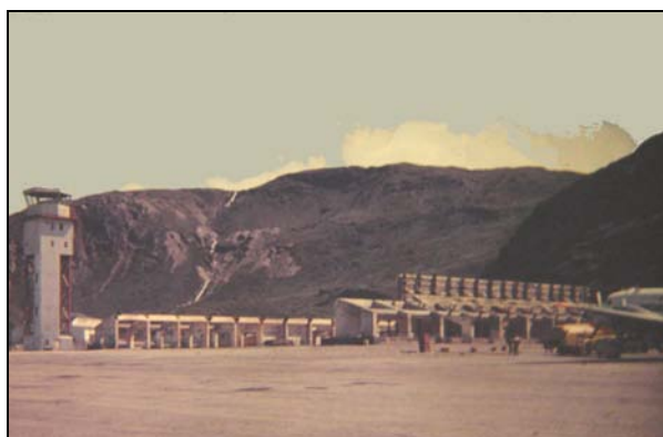
Den store hangar blev ikke genopført efter hangarbranden i 1963. I stedet måtte flyvepladsen i en årrække nøjes med at parkere flyene bag en 9m høj og 43m lang læmur, opført på resterne af den oprindelige hangar. I de år betød de mangelfulde faciliteter at Iscentralen hyppigt måtte operere ud af Reykjavik eller Søndre Strømfjord. Foto: Hans Valeur
